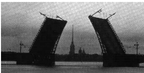
Nevan ylittävä silta
